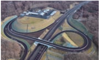
苫小牧中央インターチェンジ
