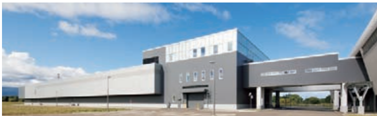
H28.12に竣工したさくらインターネット(株)の石狩データセンター3号棟
