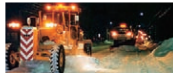
降雪時には機動的に除雪を実施
