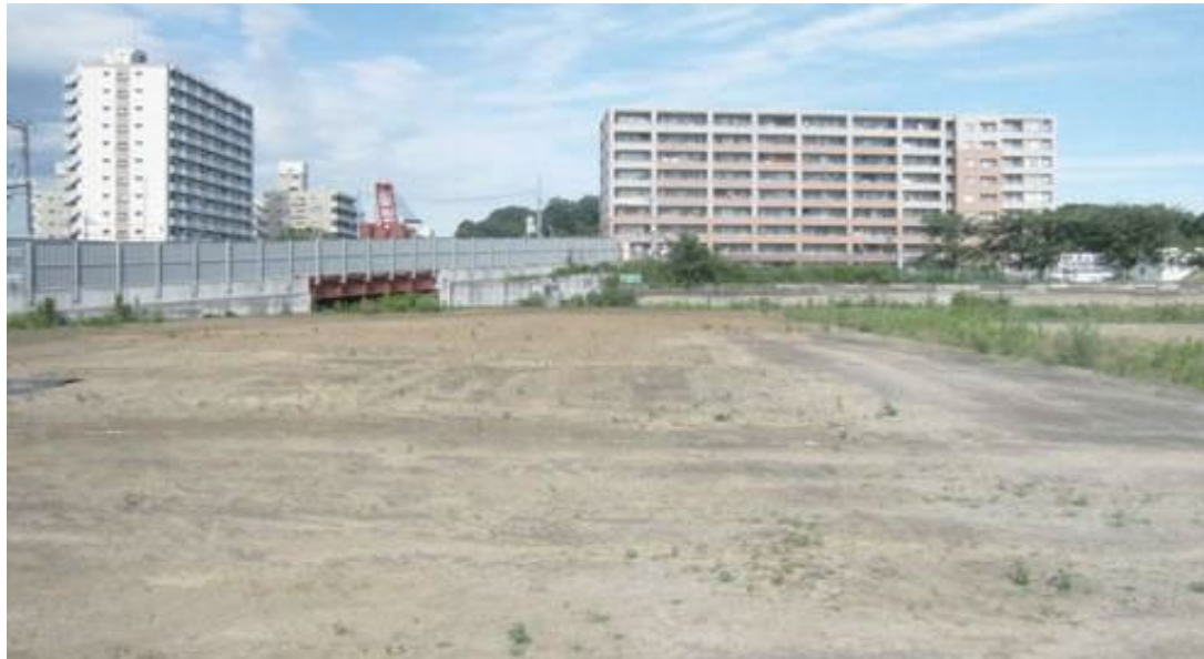
粉塵飛散防止材の施工した地面
